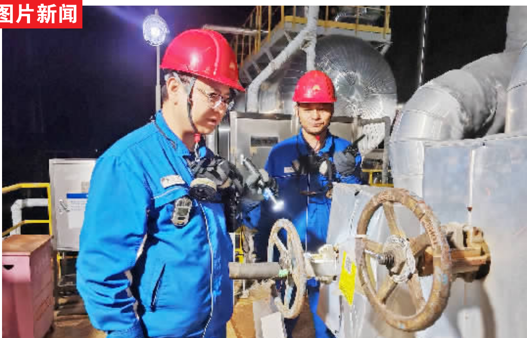
↑9月15日晚,公用工程部各装置在岗员工增加巡检频次,重点关注大机组平稳运行,严格按照规定对转动设备测温、测振。中秋小长假期间,公用工程部加大巡检及监盘力度,实行管理人员和班组员工双巡检模式。岗位员工严格执行生产管理和操作规定,全面排查隐患并落实整改措施,确保装置运行平稳。
